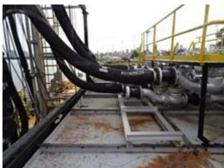
ภาพที่ 2-2 ถาดรองรับน้ำมันที่อาจรั่วไหลจากการถอดและเชื่อมต่อในการขนถ่ายน้ำมันที่ท่าเรือ
