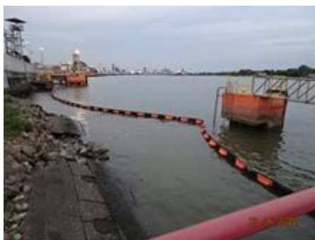
ภาพที่ 2-3 การล้อมท่อน (Boom) รอบลำเรือบรรทุก
