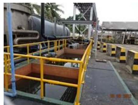
ภาพที่ 2-8 บ่อดักคราบน้ำมัน (Oil interceptor)
