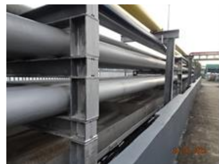
ภาพที่ 2-2 ถาดรองรับน้ำมันที่อาจรั่วไหลจากการถอดและเชื่อมต่อในการขนถ่ายน้ำมันที่ท่าเรือ
