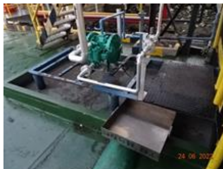
ภาพที่ 2-2 (ต่อ) ถาดรองรับน้ำมันที่อาจรั่วไหลจากการถอดและเชื่อมต่อในการขนถ่ายน้ำมันที่ทำเรือ
