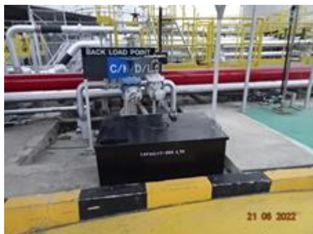
ภาพที่ 2-2 (ต่อ) ถาดรองรับน้ำมันที่อาจรั่วไหลจากการถอดและเชื่อมต่อในการขนถ่ายน้ำมันที่ทำเรือ
