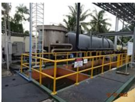
ภาพที่ 2-8 บ่อดักคราบน้ำมัน (Oil interceptor)
